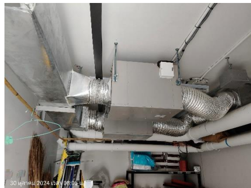
พัดลมดูดอากาศภายในห้องพัสดุเปียง
